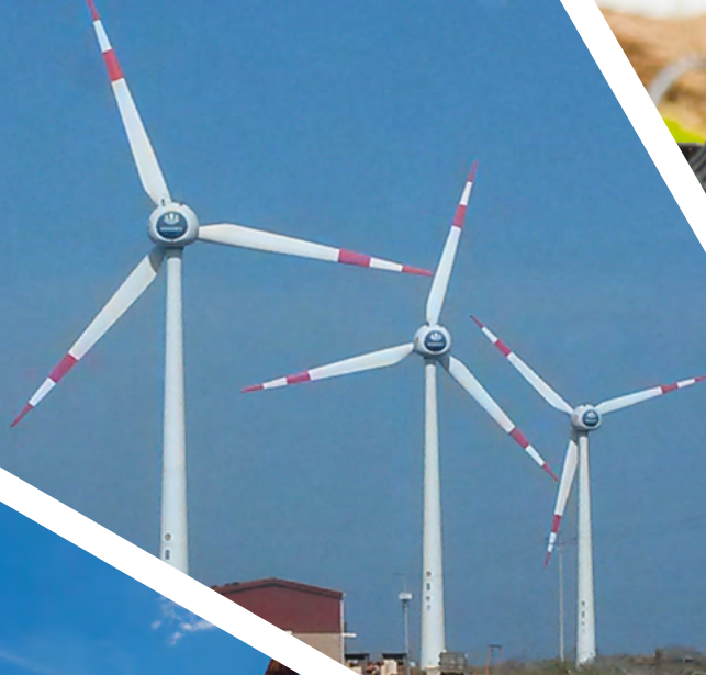
Central eólica Baltra Galápagos E.E. Galápagos
