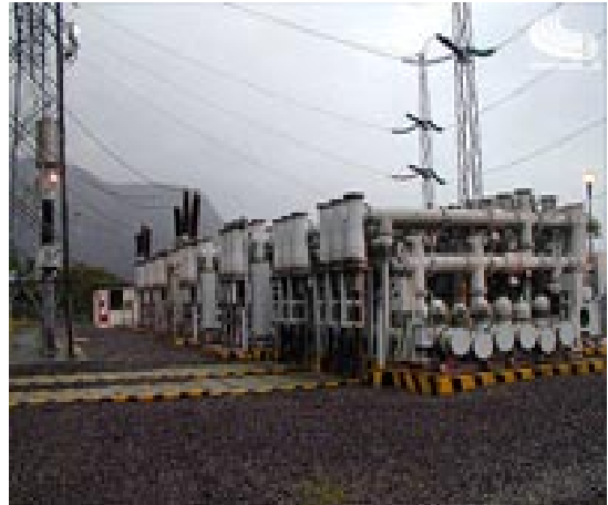
Figura 2-1: Patio de Maniobra Hidropaute
