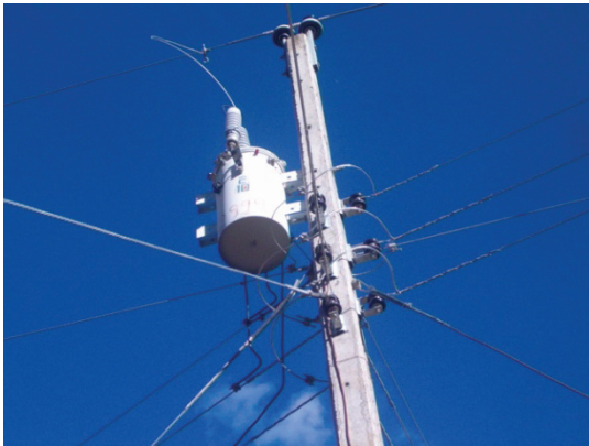
Figura 4-1: Centro de transformación para usuarios finales
